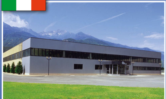
AUTOBLOK Werk in Caprie-Torino
